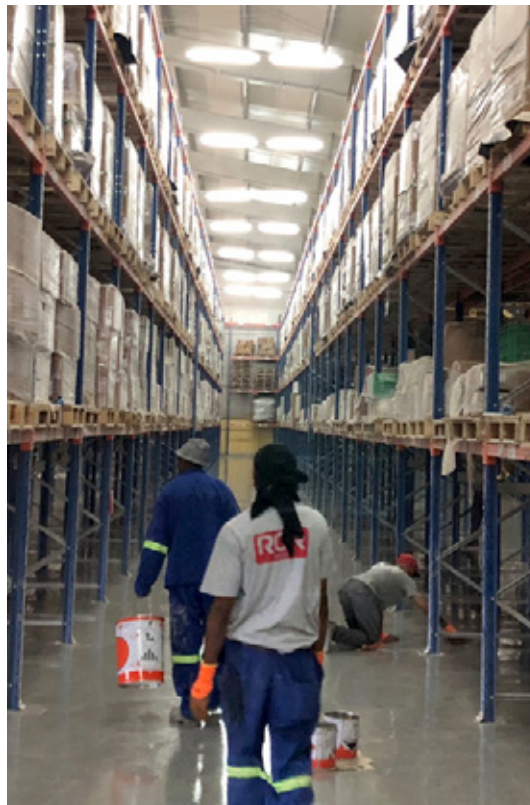
Renovación de almacén - Etiopía
