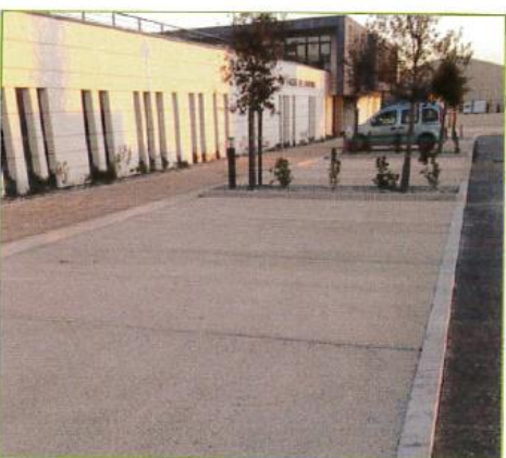
La Tour d'Aigues : les places de parking achevées, quelques jours avant l'inauguration.
