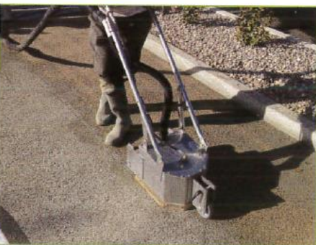
La Tour d'Aigues : grâce à un nouveau procédé, il est désormais possible de gommer une très fine couche de laitance et de faire apparaître les granulats sans obstruer les vides du béton drainant.
