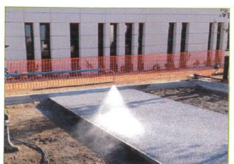
La Tour d'Aigues : en plus d'un nouvel additif introduit dans le béton, un produit permettant de révéler les granulats a été pulvérisé.
