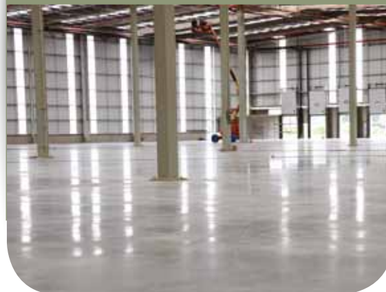
Vista general de la instalación
