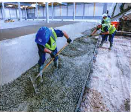
Réalisation d'un dallage industriel effectuée par une équipe de Placeo.
